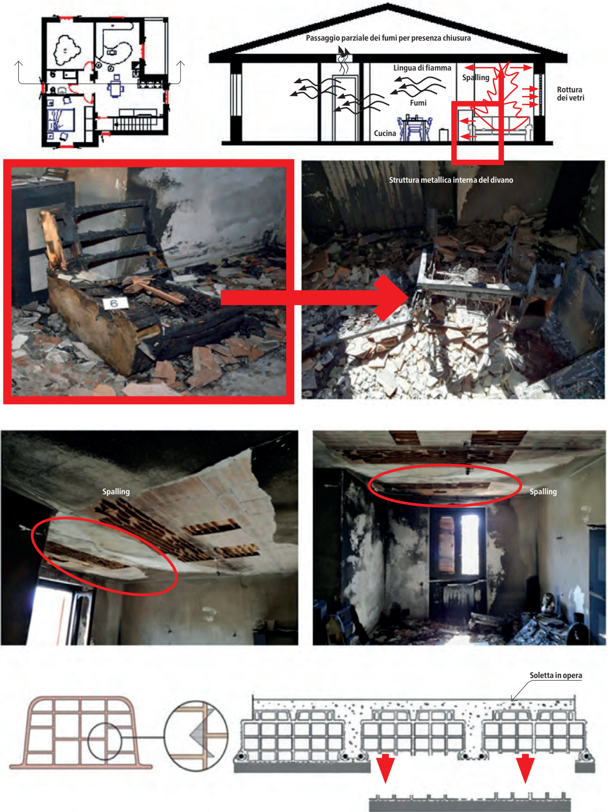
Figura 3 | Distruzione di un divano e danni al solaio in un incendio doloso
